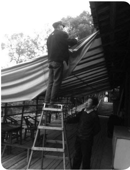
张叔和马叔在修理屋前的雨篷
