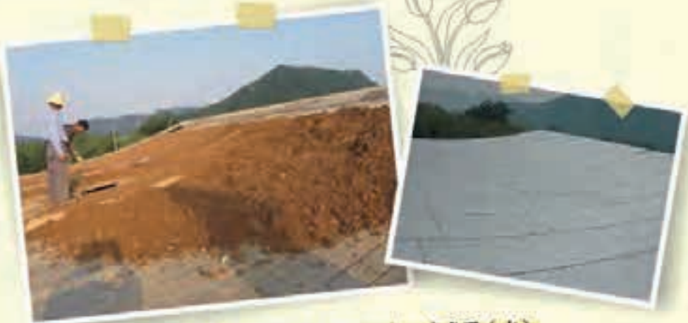
三号屋的屋面：铺粘土中（左），完成图（右）
