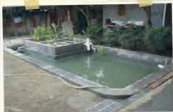
家园污水人工湿地概貌
