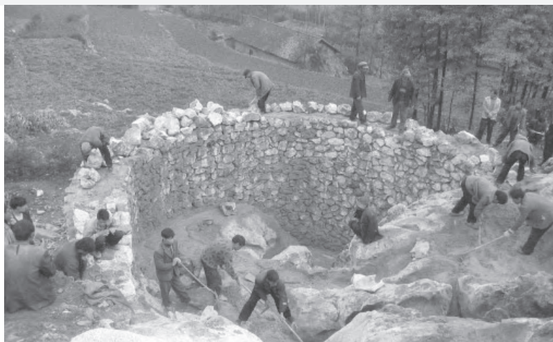
在贵州威宁县可持续生计项目中的水池建造 Water tank construction in Weining Sustainable Livelihood Programme, Guizhou
